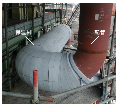
写真2 けい酸カルシウム保温材の取付け状況
