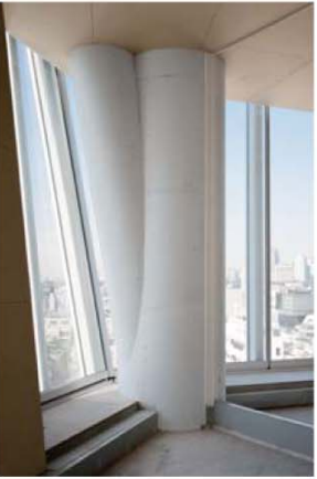
(↑写真5) タワー部のテナントフロア。丸柱の耐火被覆にK-ブリッドコラムが採用されている。
