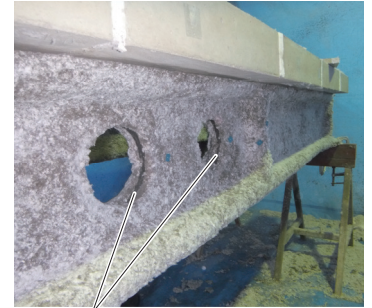
すりふたすけ (ロックウール吹付け後)
