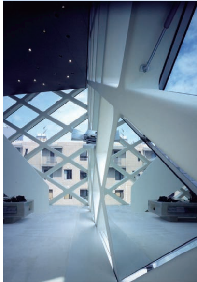
菱形構造フレームへの施工 / 店舗
