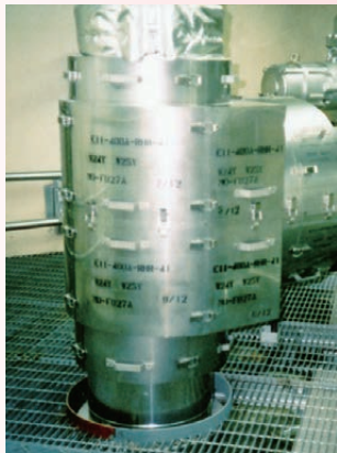
原子力配管金属被覆保温
