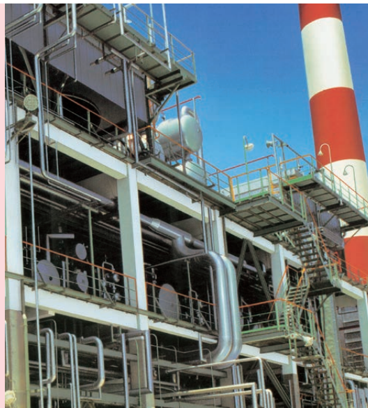
プラントストラクチャーの鉄架構の耐火被覆
