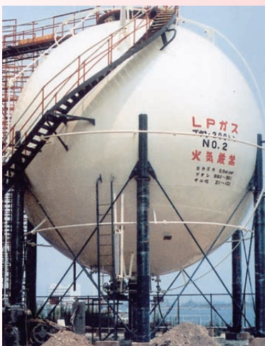
貯槽支柱（丸柱）の耐火被覆
