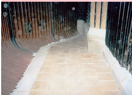
ボイラ内部の煉瓦積みとキャストابل
