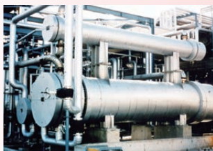
熱交換器（着脱カバー）
