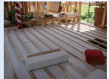
Baubio-断熱N / 床断熱
