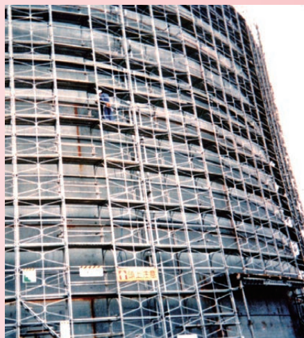
タンク仮設足場
