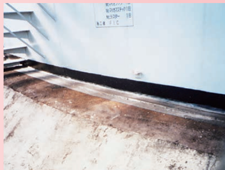
防水防食工事
