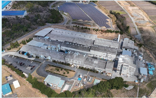
北勢工場（三重県いなべ市）
