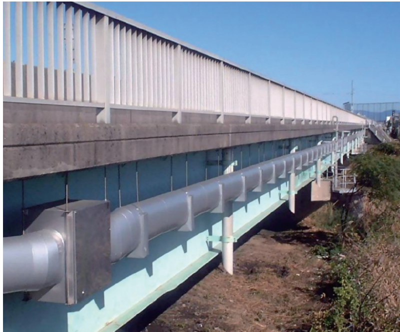
JIC セラミック積層工法／橋梁
