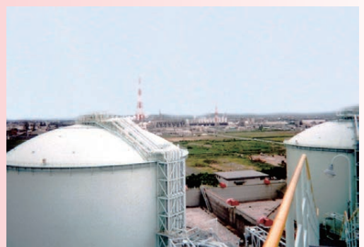
LNG タンク保冷
