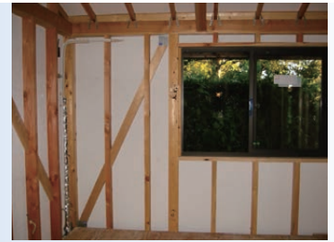
Baubio-断熱N / 壁外張断熱
