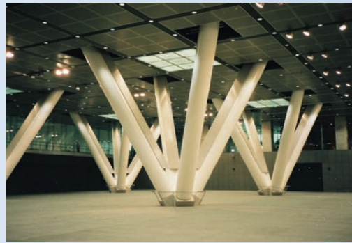
大型丸柱への施工 / 大型ホール
