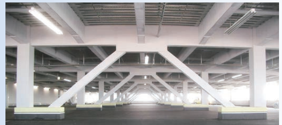
はり・柱・ブレースへの施工 / 店舗駐車場
