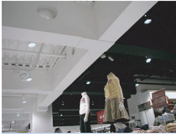
はりへの施工 / 店舗
