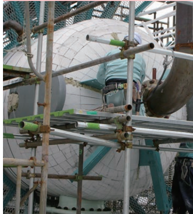
ブロックミラー施工中
