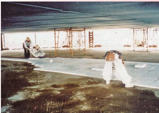
タンク下の地表面断熱工事
