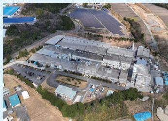
北勢工場 (三重県いなべ市)
