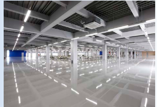
はり・柱の施工 / 物流施設
