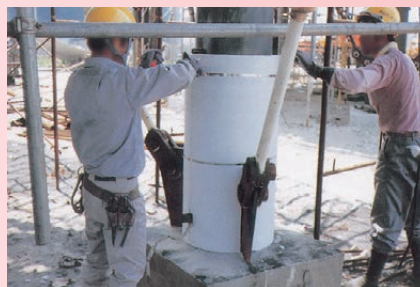
貯槽支柱（丸柱）の耐火被覆
