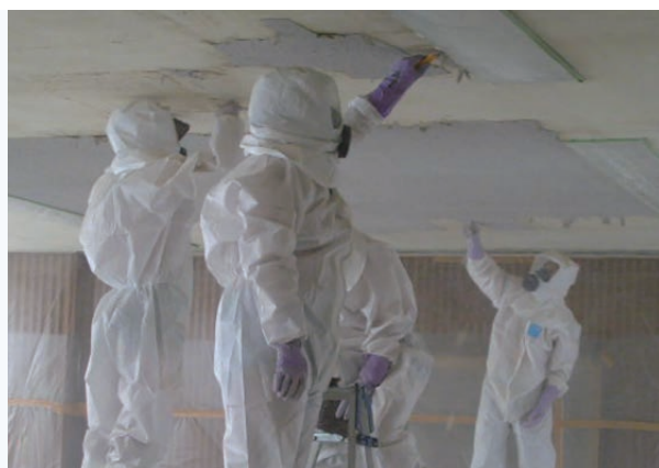
アスベスト含有吹付け建材除去作業
