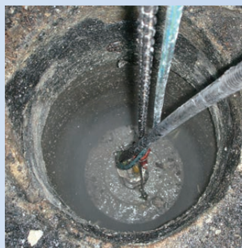
高圧水によるアスベスト含有煙突用けい酸カルシウムライニング材除去作業
