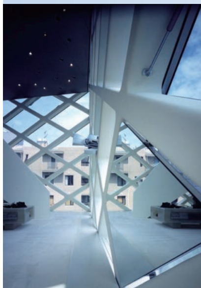
菱形構造フレームへの施工 / 店舗
