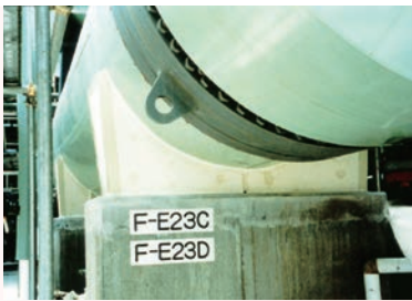
機器サドル部の耐火被覆
