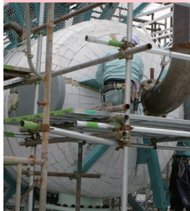
ブロックミラー施工中
