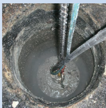
高圧水によるアスベスト含有煙突用けい酸カルシウムライニング材除去作業
