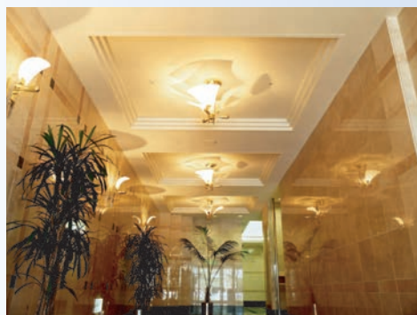
照明周り見切り / 集合住宅ロビー
