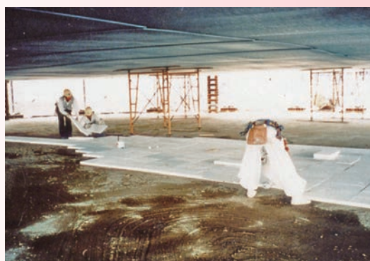
タンク下の地表面断熱工事
