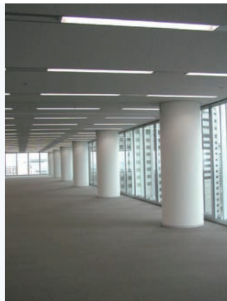
丸柱への施工 / 事務所ビル
