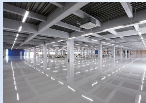
はり・柱の施工 / 物流施設
