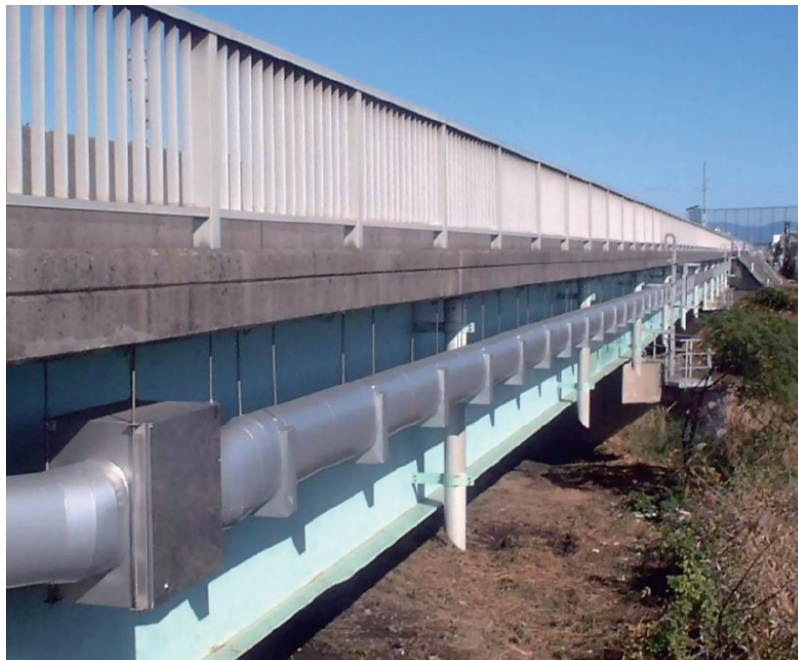
JIC セラミック積層工法／橋梁
