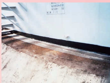
防水防食工事
