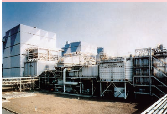
発電プラントの排気ガスの脱硝、脱流、集塵施設
