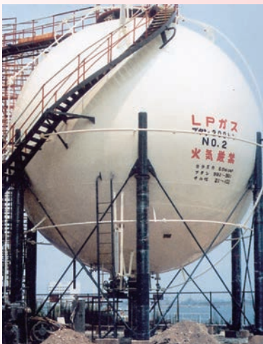
貯槽支柱（丸柱）の耐火被覆
