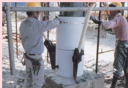
貯槽支柱（丸柱）の耐火被覆
