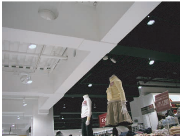
はりへの施工 / 店舗
