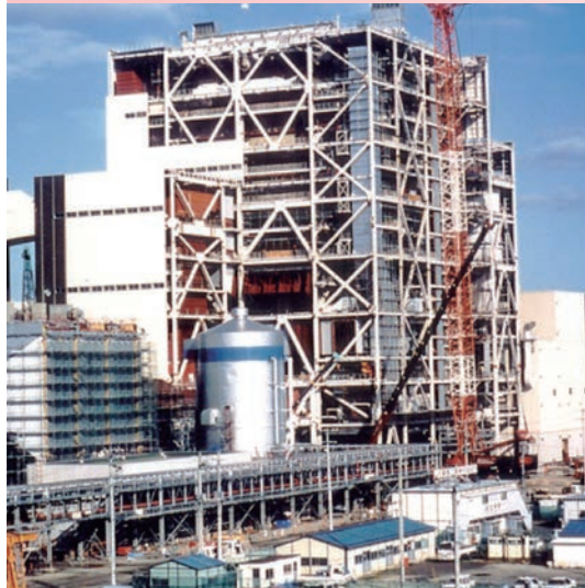
電力石炭焚ボイラ
