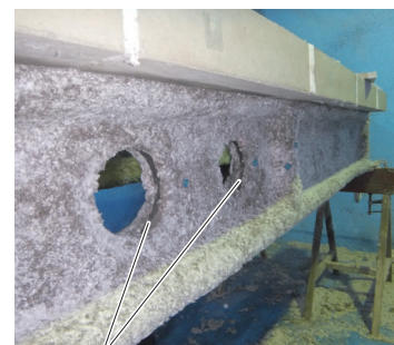
すりーぶたすけ (ロックウール吹付け後)
